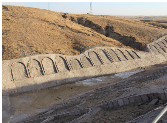
北侧泄洪沟浆砌石护壁
